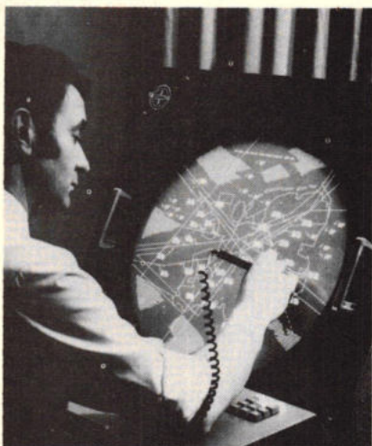
Afb. 76. Proefopstelling van het bijna vlakke 23" daglicht beeldscherm t.b.v. SARP.
