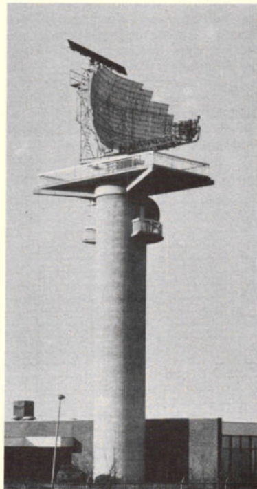
Afb. 72. Lange afstand radar te Herwijnen (Betuwe) met boven op de primaire antenne de secundaire. Direkt onder het torenplatform is de straalverbindingparabool nog net zichtbaar.
